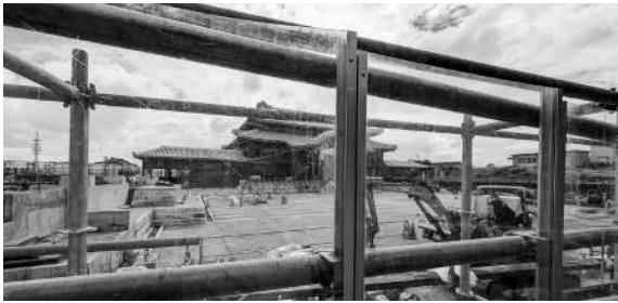
復元工事エリア
